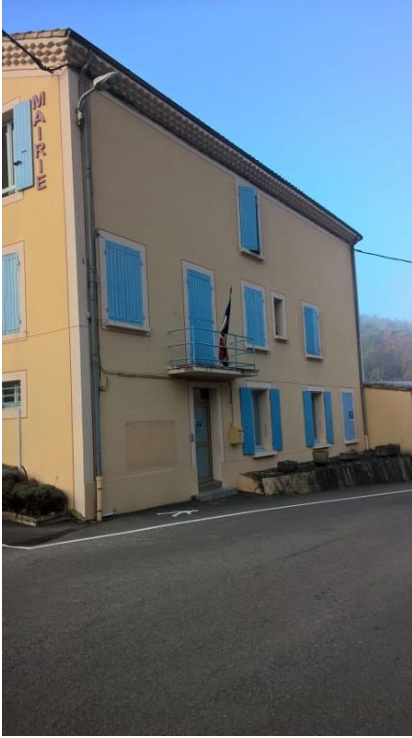
Façade coté RD107, poste 1
