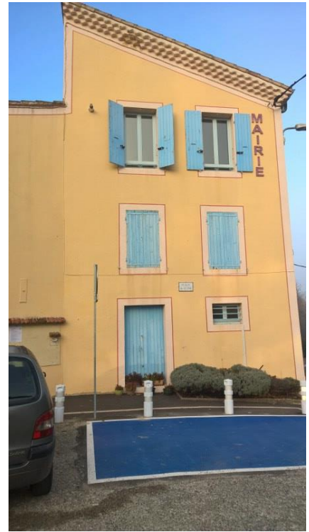
Façade coté garage communal, poste 2
